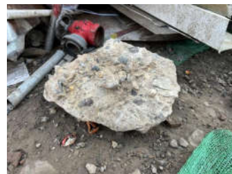
图7 胶凝状混凝土硬块图
