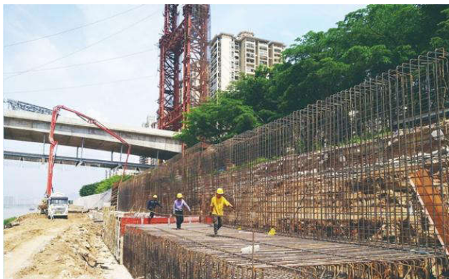
堤防加固如图一所示
