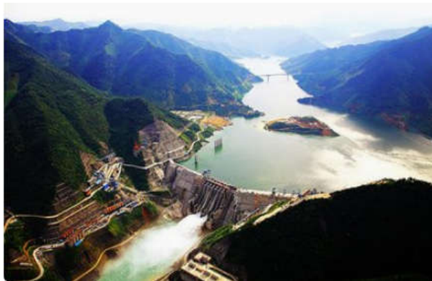
图1 水利水电工程
