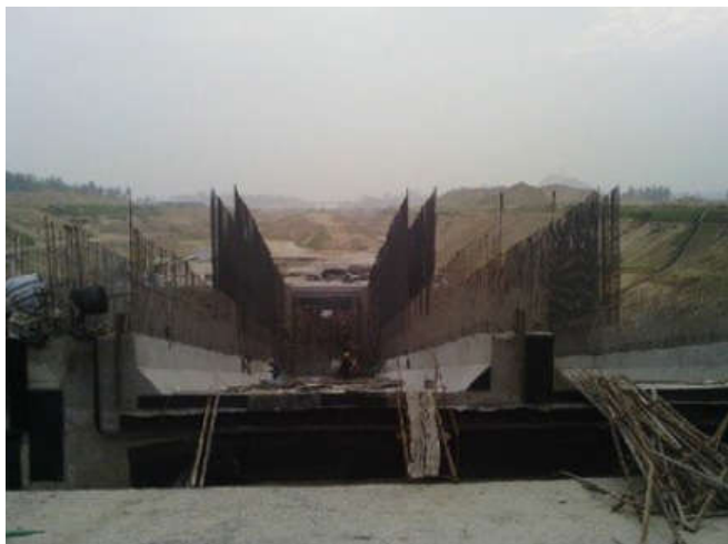
图2 水利水电工程施工
