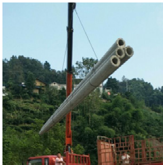
图1 高危环境下的水利水电施工
