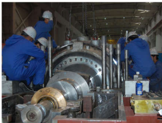
图3 某火力发电厂锅炉维修过程
