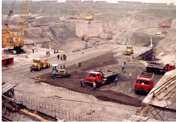
图3 水利水电工程喷混凝土施工
