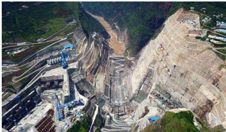
图1 水利水电工程中边坡建设
