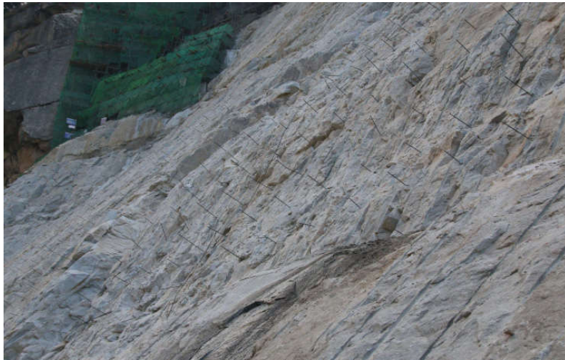
图2 右坝肩锚杆施工
