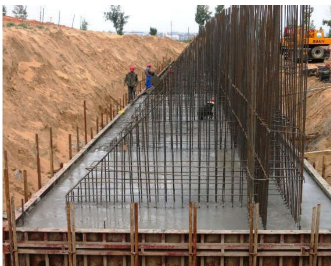
图2 水利工程混凝土浇筑
