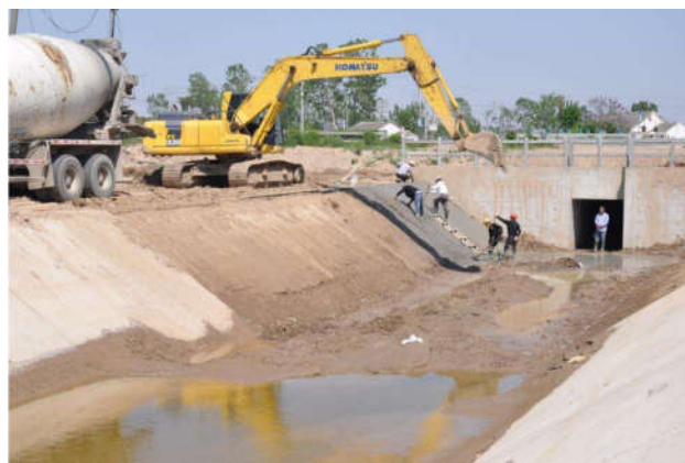
图1 水利工程建设现场
