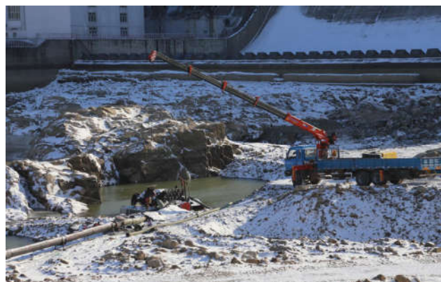
图3 浮箱式船泵站在丰满重建工程大型基坑抽排水中的实际应用
