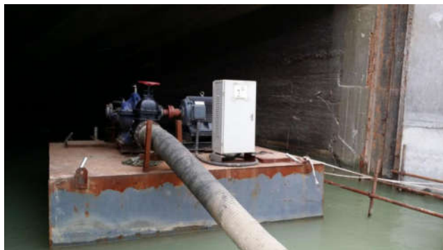
图1 浮箱式船泵站在丰满大坝重建工程老坝渗水抽排中的实际运用（为丰满大坝重建工程旧厂房坝段尾水处的一台装有75kw功率的浮箱式泵站）
