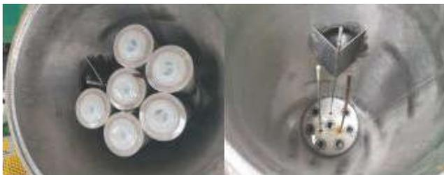
图5-1 反渗透进口保安过滤器
