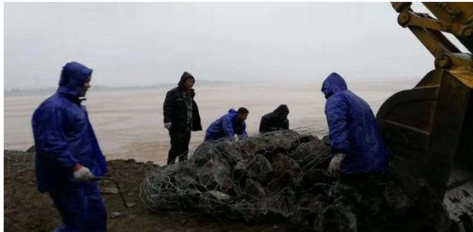
图4 新乡黄河河务局封丘黄河河务局机械装抛铅丝石笼技术
