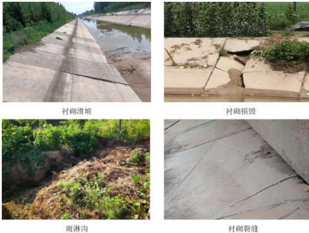
图2 渠道水毁图像示例
