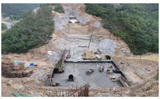
商南县清油河水库在浇筑前先做碾压混凝土试验,根据骨料特性及其他参数确定合理的碾重、行车速率、铺料厚度、碾压遍数、VC值等压实参数,确保水库大坝混凝土施工质量。混凝土浇筑采用自卸汽车场内运输,推土机摊铺作业,摊铺厚度、碾压遍数、行走速率等参数严格按照碾压试验数据控制,施工过程中采用3m高度大模板,滑模施工,保证了碾压混凝土施工,施工后夏季按试验采取洒水养护,冬季搭棚保温养护,保证混凝土完成凝固后的质量<sup>[4]</sup>。
