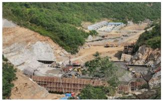
4.1.3 商南县清油河水库累计浇筑混凝土15.7万m³,其中常态混凝土约1.2万m³、变态混凝凝土(碾压混凝土加浆)1.5万m³、碾压混凝土13万m³,混凝土浇筑方量较大。砂石骨料等主要原材料保障就非常重要了,商南县清油河水库原设计及招标文件中明确水库大坝砂石骨料为大坝上游2公里处牛金石料场,但是由于林地手续及开采手续问题,该料场无法使用,施工单位对现场情况查勘后决定对大坝、改建淹没公路石方开挖的石料进行加工利用,对清油河河道部分砂砾石料开采使用,但是前提是这些石料的性能要符合碾压混凝土大坝骨料要求,经过中水十五局实验室反复试验,大坝、改建淹没公路石方开挖的石料、清油河河道部分砂砾石料相关参数满足大坝碾压混凝土相关要求,大坝砂石骨料问题得到了解决<sup>[3]</sup>。
