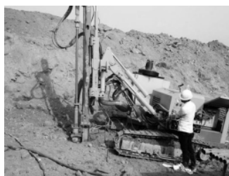
图1 钻孔现场施工图
