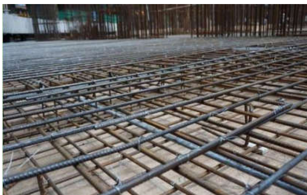
图2 钢筋安装施工技术
