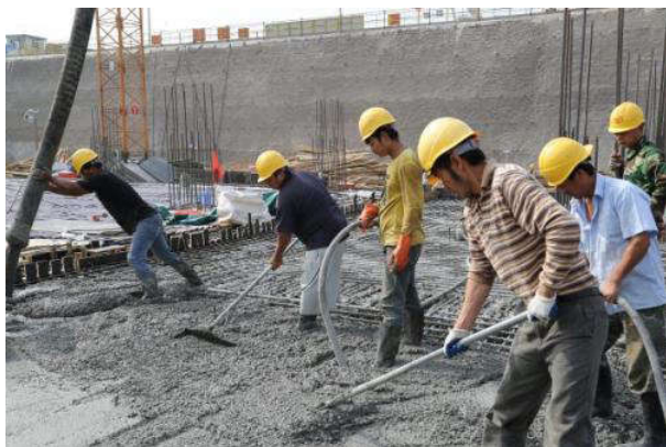
图1 混凝土浇筑技术与施工
