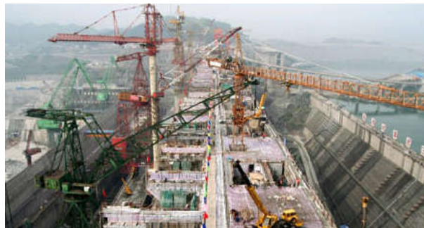
图3 三峡大坝建设中分缝分块施工
