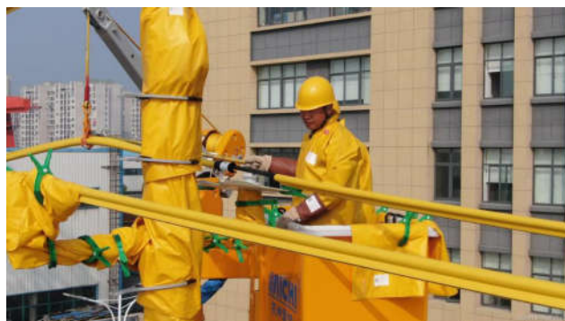
图1 带电更换10kv架空线路直线杆绝缘子 (绝缘手套作业法)
