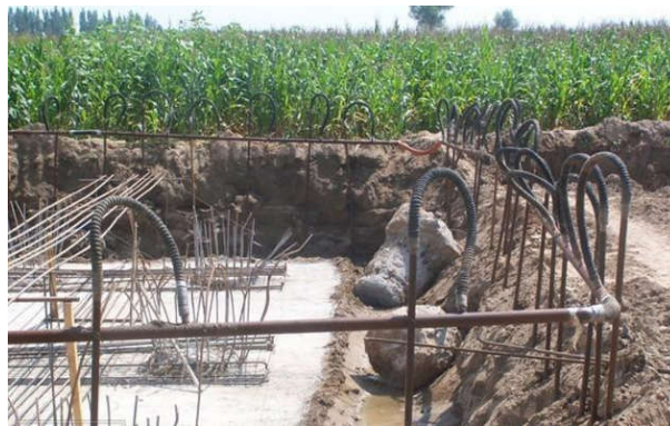
图2 井点法排水施工技术
