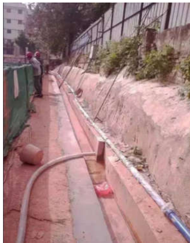
图1 基坑明沟排水施工技术
