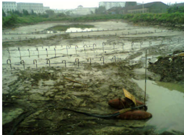
图3 降水法施工技术
