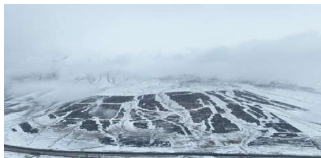
图5 西藏华电拉萨曲水茶巴拉100MW光伏发电项目光伏区全景
