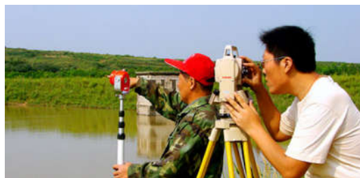
图1 水利工程的施工测量
