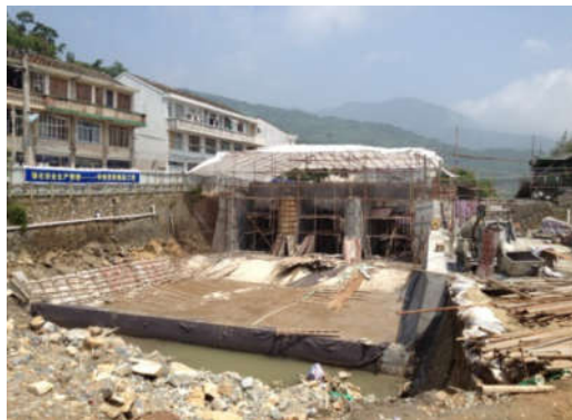
图2 水闸前期施工图
