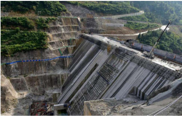
水利水电工程施工如图所示
