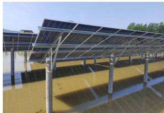
附图1 坑塘光伏支架实景图；
