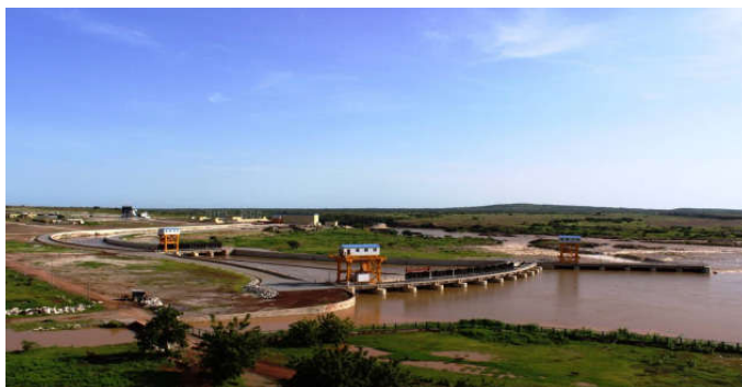
图1 马里费鲁水电站全貌
