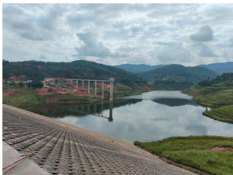
竖井式分层取水施工完成后照片
