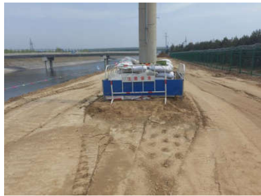
图1 土袋临时防护
