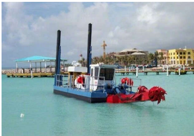
图3 港池疏浚施工图
