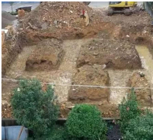
图1 基槽开挖施工图
