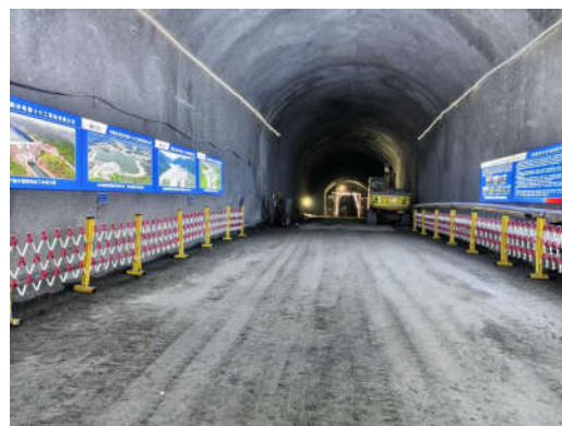
隧洞施工形象照片
