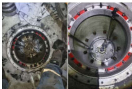
图1:矿热炉变压器检修现场实物图
