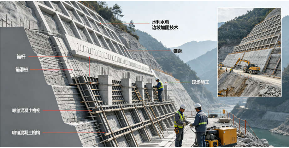
图1 水利水电工程边坡加固技术现场图
