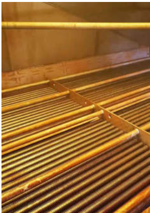
图4 加热器换热管冲洗后实物图
