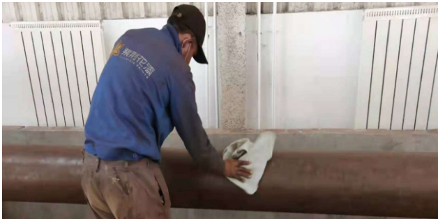
(b) 打磨除锈处理过程中
