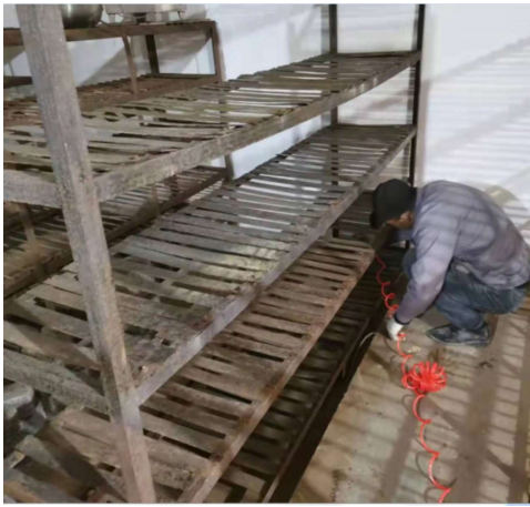
(b) 打磨除锈喷涂“科来新”后
