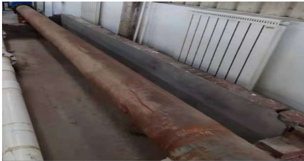
(a) 打磨除锈喷涂前状况
