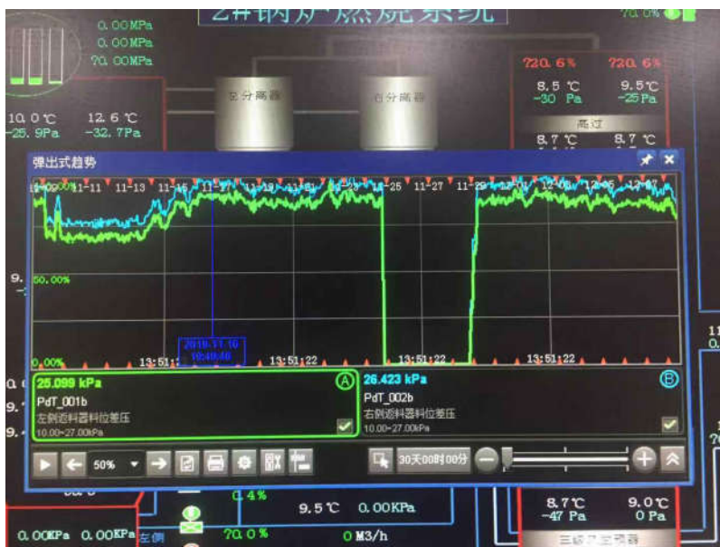
图一：2#锅炉左右侧返料器料位差压最大接近1.5Kpa左右
