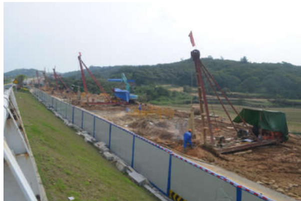
图2 明挖现浇施工现场
