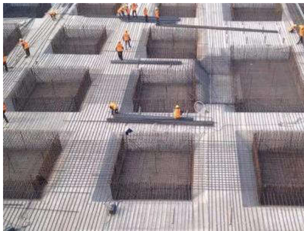
图1 地基基础工程施工现场
