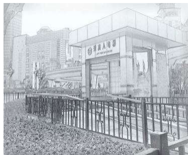
图6 无障碍专用电梯间
