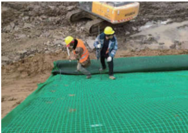
图8 坡面土钉施工
