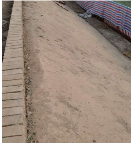
图6 边坡修整照片
