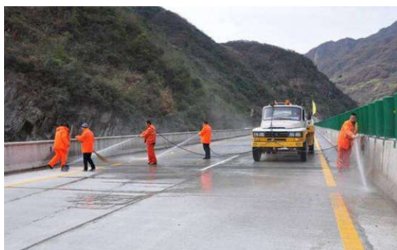
图3 道路桥梁养护
