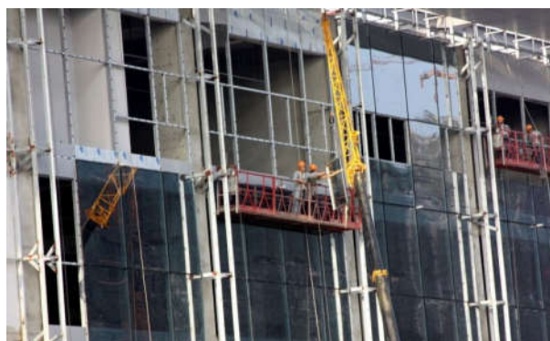
图3 玻璃幕墙的玻璃安装
