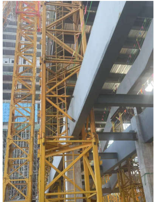
图6 一架多用穿越双层梁实体图
