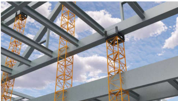
图10 一架多用穿双层梁设置BIM模拟图
