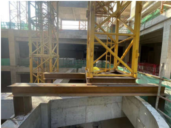
图4 现场跨洞口支架实体图
