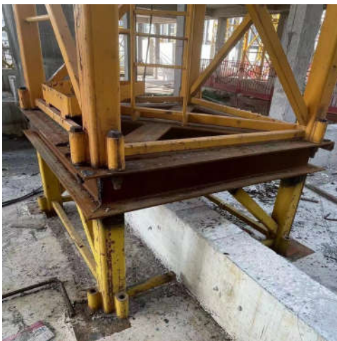
图5 骑结构反坎支架设置实体图
