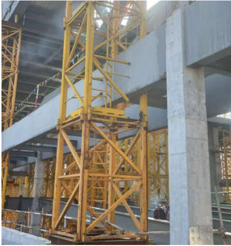
图3 骑结构梁支架设置实体图
