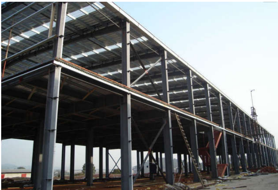
图2 钢结构的工业厂房建设
