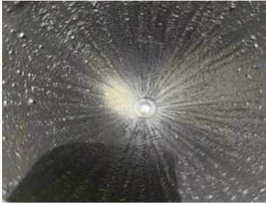
图1 孔内漏浆最深17m
