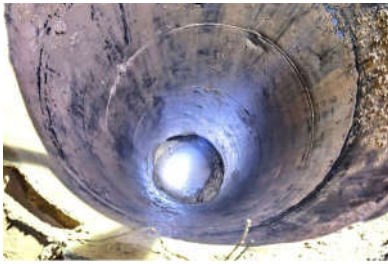
图2 护筒底卵石与岩石交界面塌孔
