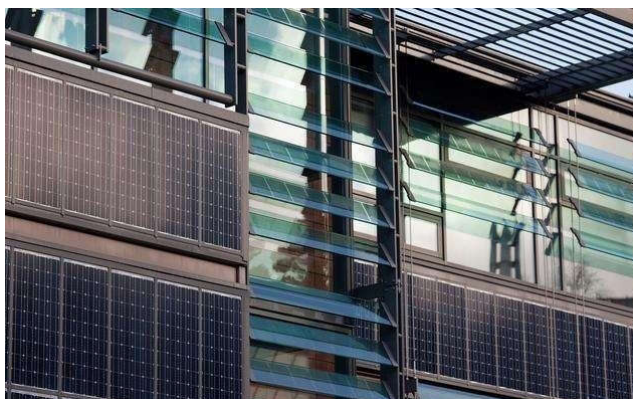
图1 太阳能光伏建筑一体化示例图
