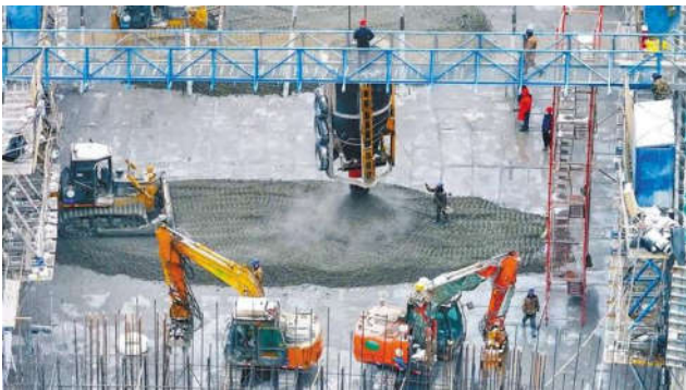
图1 某工程大坝混凝土浇筑现场
