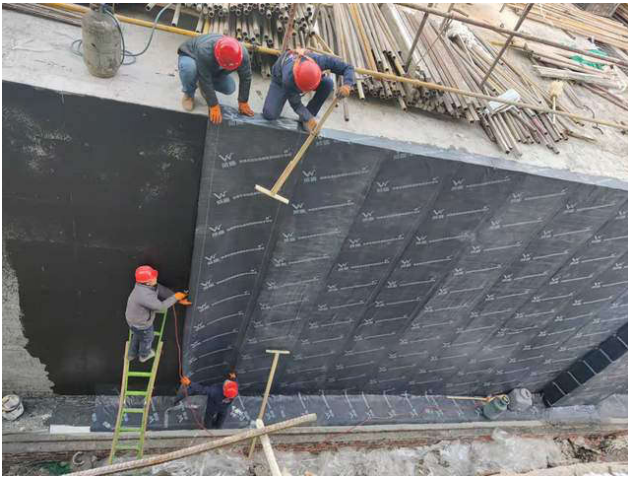
图1 防水涂料、防水卷材等防水层材料的施工
