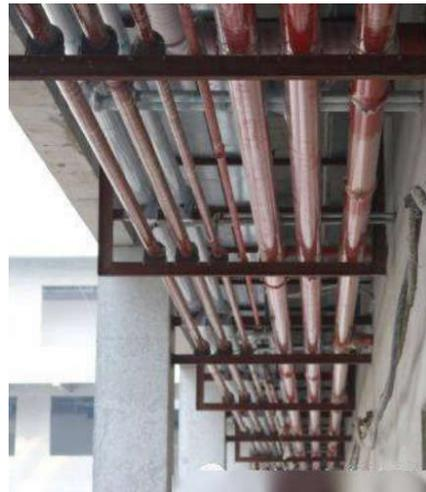
图3 管道支架安装
