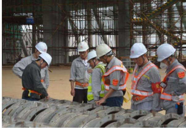
图1 建筑施工现场安全检查
