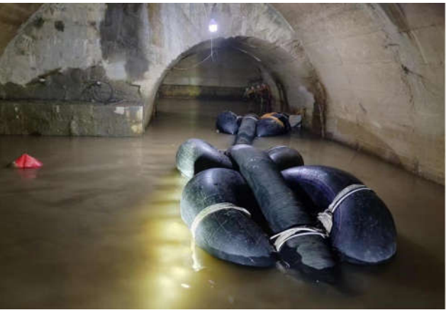
图3 布置吹砂管道
