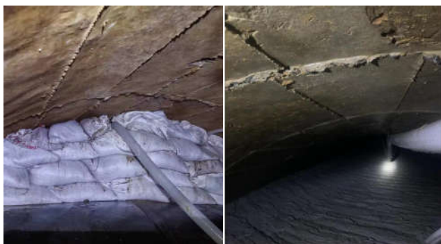
图6 顶部空隙注浆
