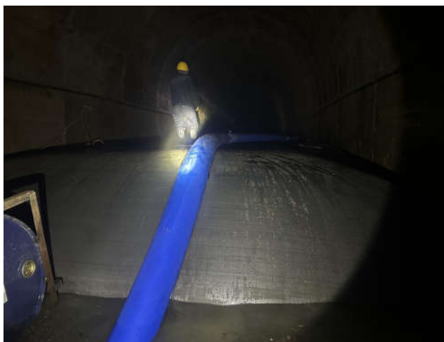
图5 洞内吹砂填筑
