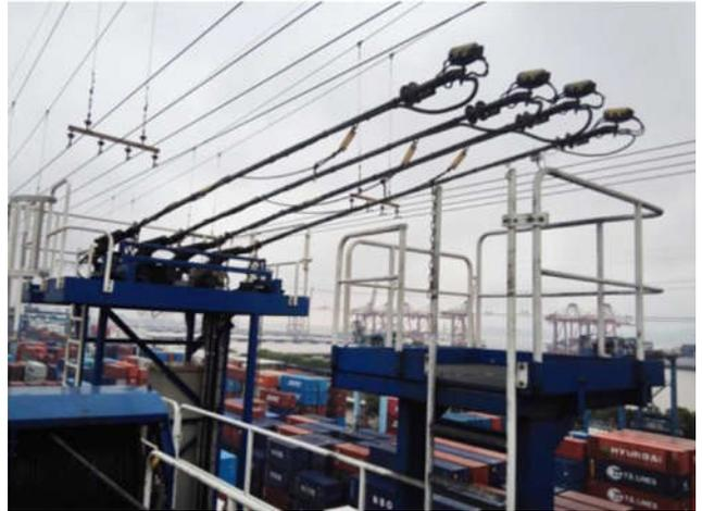
图4 高空架设滑触线
