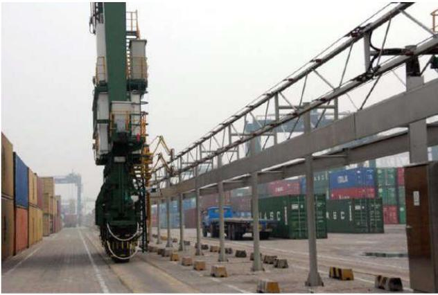
图2 低空架设滑触线
