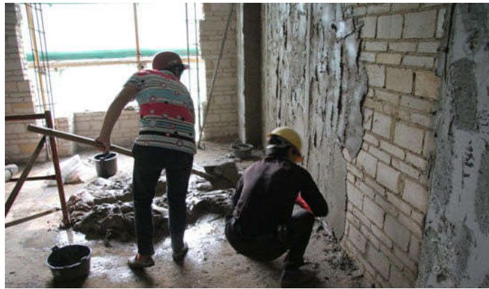
图1 墙面抹灰工作
