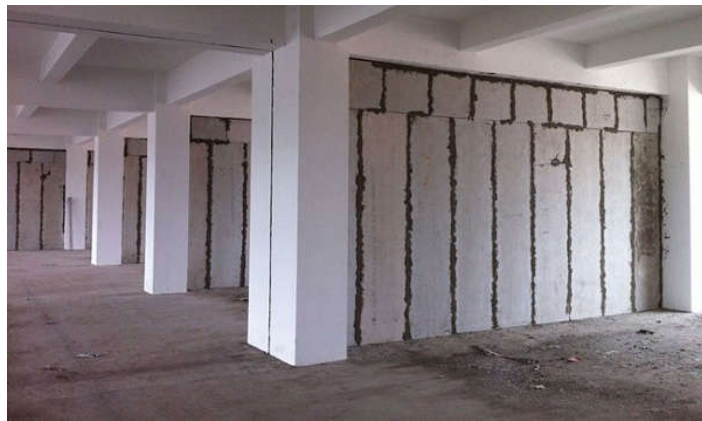
图2 轻质隔墙工程
