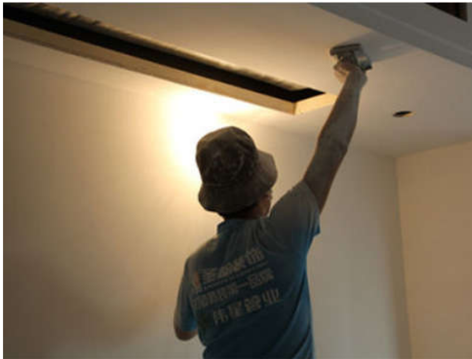
油漆打磨工程，墙面腻子一底两面，再打磨
