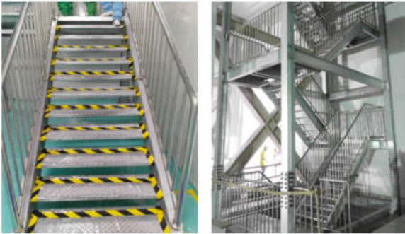
图3 扶手安装及完成效果
