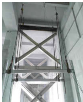
图1 立柱安装情况
